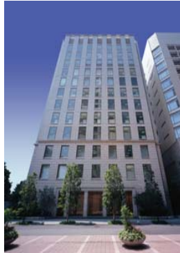
淀屋橋フレックス タワー
