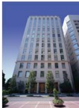
淀屋橋フレックス タワー
