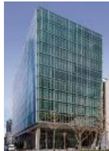
明治安田生命 大阪御堂筋ビル (大阪府大阪市)
