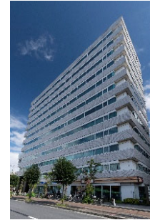
ルーシッドスクエア 新大阪 (大阪府大阪市)
