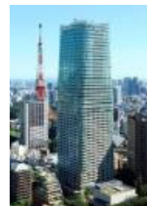
アークヒルズ 仙石山森タワー (東京都港区)
