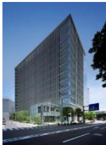
横浜プラザビル (神奈川県横浜市)
