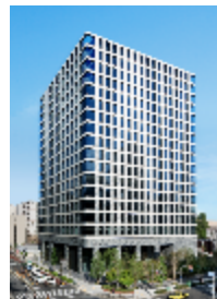
土佐堀ダイビル (大阪府大阪市)
